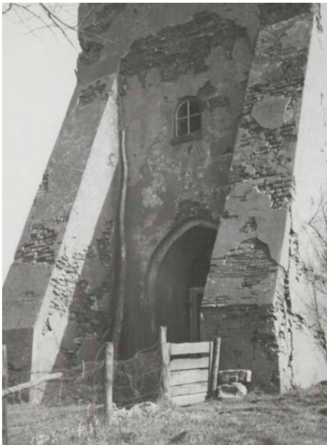
De steunberen van de toren, foto uit circa 1955.
